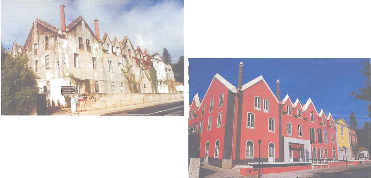
Figura 4 – Centro Cultural de Cascais, antes e depois da reconstrução (antigo Convento de Nossa Sr.ª da Piedade e, posteriormente, edifício Gandarinha)
