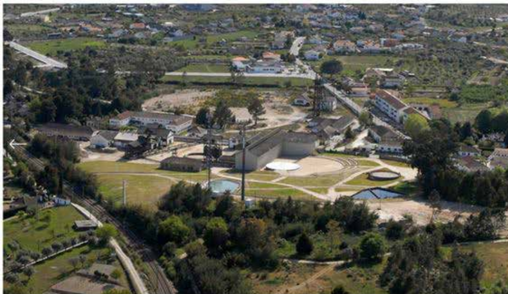
Figura 7 – Vista aérea da mina de Urgeiriça.
