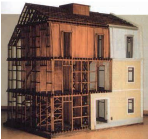
Figura 6 – Maquete do «sistema de gaiola» de edifícios pombalinos
