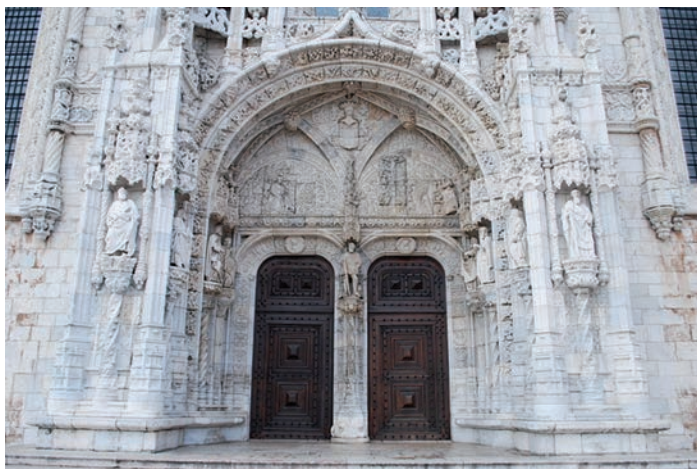
Figura 3 – Igreja de Santa Maria de Belém do Mosteiro dos Jerónimos, século XVI, portal sul
