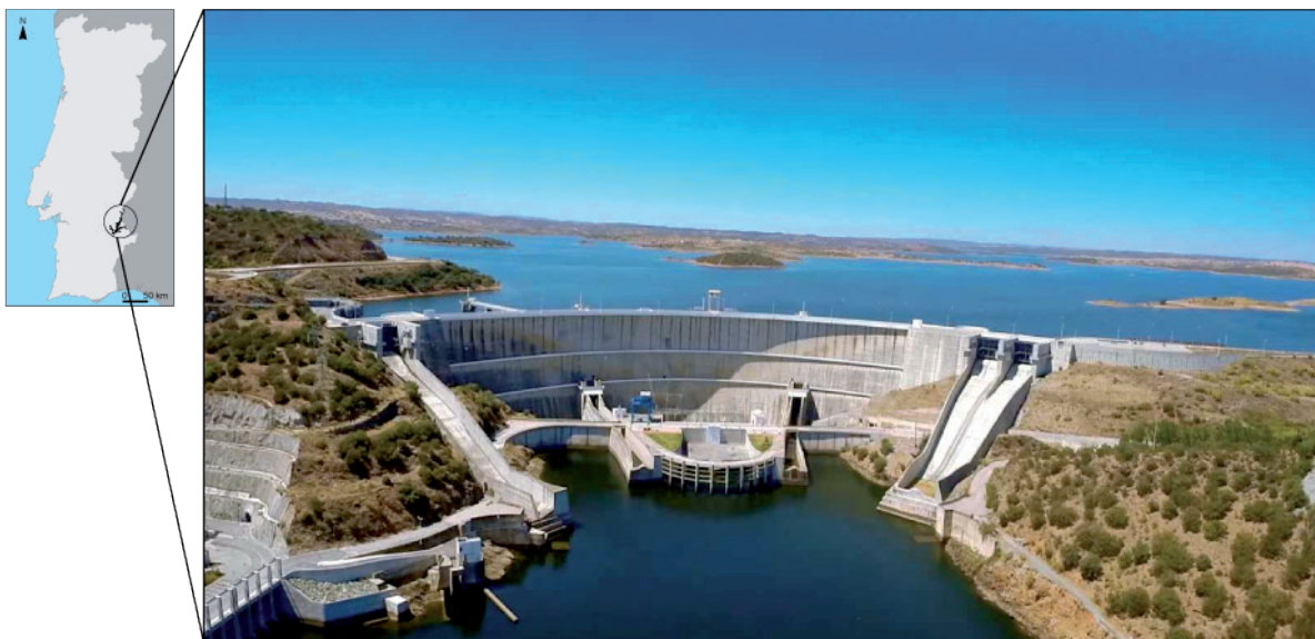
Fotografia A – Barragem do Alqueva.
